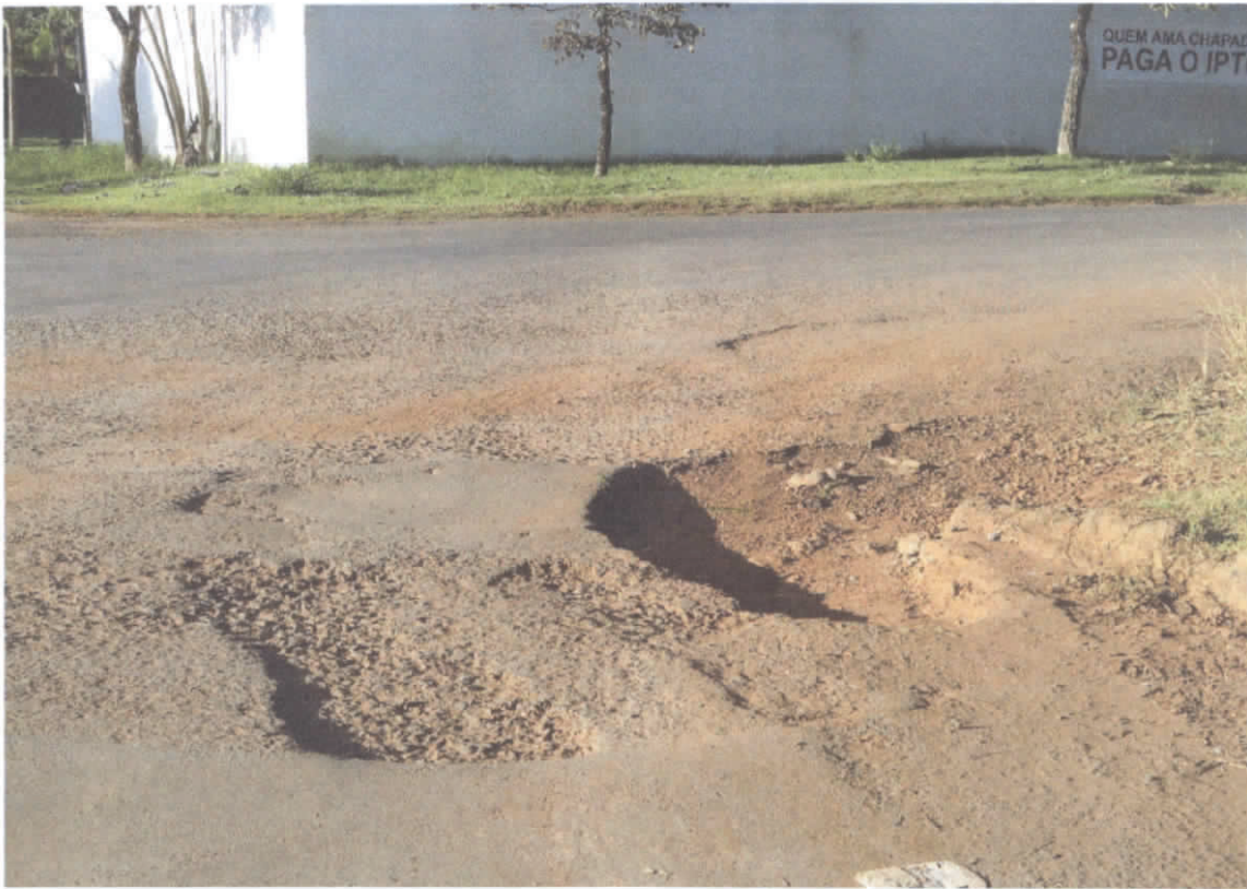
Rua 19, esquina com 08, Bairro Adolfo Koberstain.
