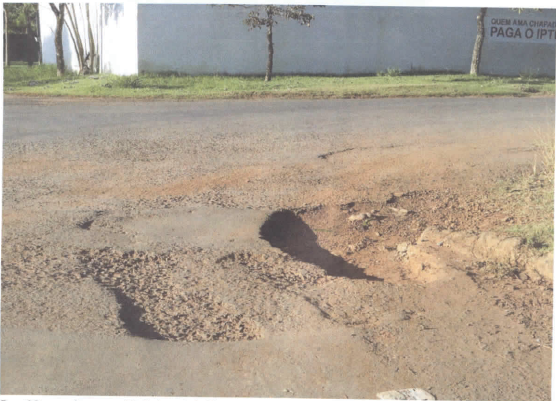
Rua 19, esquina com 08, Bairro Adolfo Koberstain.
