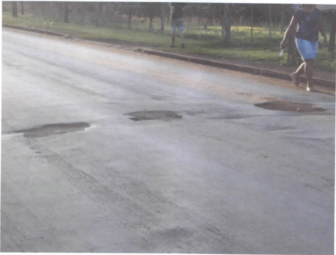
Av. Principal Bairro São Sebastião, prox. CEMEI.
