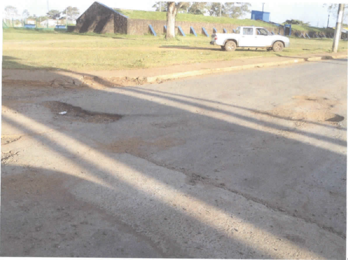
Rua Arica, prox. a esq. do mini Estádio e SAAE.
