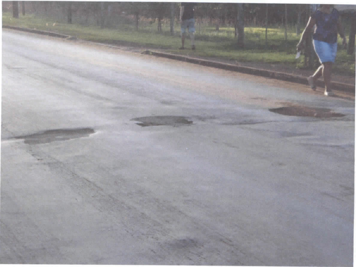
Av. Principal Bairro São Sebastião, prox. CEMEI.
